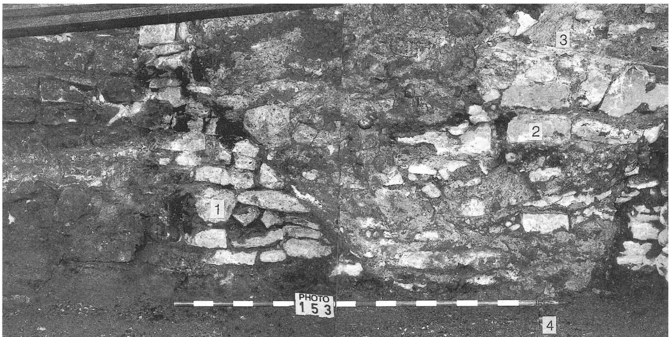
Abb. 30b. Fundament des südlichen Seitenschiffs über Latrine 3, Blick nach Südosten. 1 Südwand Latrine 3; 2 Fundament Entlastungsbogen; 3 Negativabdruck Balken; 4 Grubensohle.
