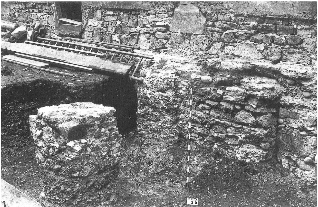
Abb. 37b. Fundamentbereich des Arkadenpfeilers 10f/9c (vgl. Faltplan B).
