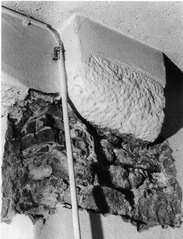
Abb. 8. Gerbergässlein 2 Nord, Hinterhaus, ehemaliger «Schwarzer Turm». Freigelegte Mauerpartie im Gang mit mittelalterlicher, in situ liegender Steinkonsole. – Foto: BaDpf. B 293/5.
