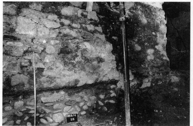
Abb. 8. Rheingasse 86, Vorderhaus: Fundamente der Hinterfassade. Zuunterst bei der Fotonummer liegt der älteste Fundamentteil, Mauer 9 (gehört wohl zu einem mittelalterlichen Kernbau), darüber das jüngere Fundament Mauer 10 (gehört wohl zur Mädchenschule des 17. Jh.), rechts hinter dem Metallspiess der jüngste Fundamentteil Mauer 3 (Neubau aus dem 19. Jh.).
