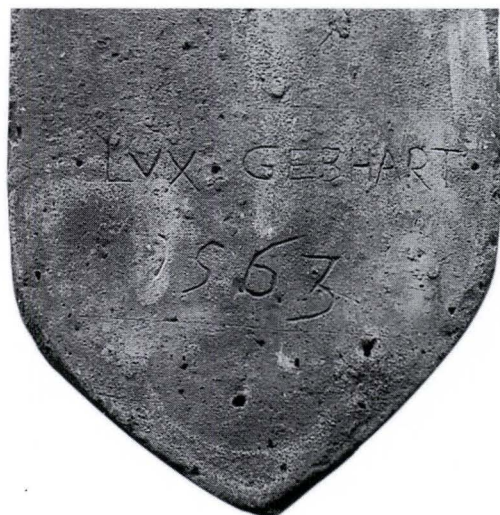
Abb. 9 Rheinsprung 7. Rückseite des Dachziegels mit der Inschrift «Lux Gebhart 1563» (Lucas Gebhart, Basler Bürgermeister, 1523–1593). – Foto: Basler Denkmalpflege (M702-17).
