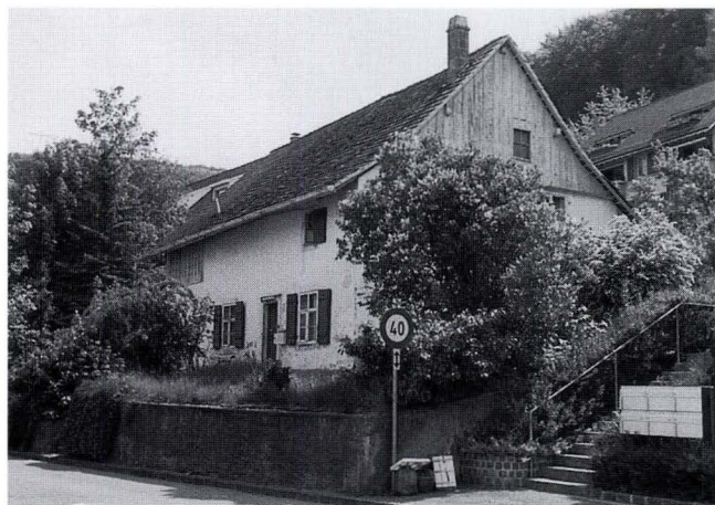
Abb. 13 Hauptstrasse 74. Ansicht. – Foto: Hans Ritzmann.
