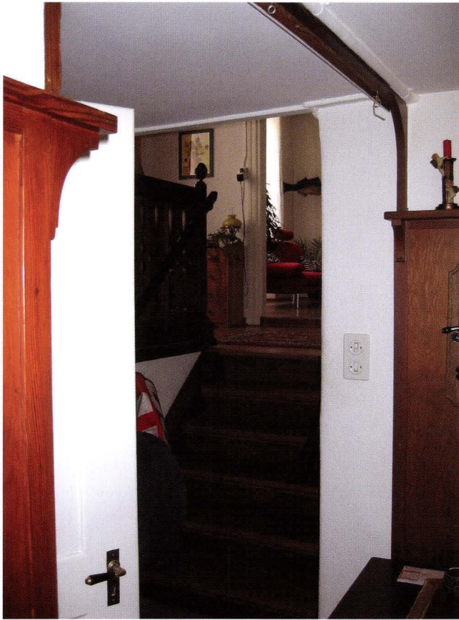
Abb. 13-11 Spalenvorstadt 11 (2004/168). Blick vom rechten zum linken Hausteil im Obergeschoss. Deutlich erkennbar ist die starke Differenz der Geschosslagen. – Foto: Basler Denkmalpflege.
