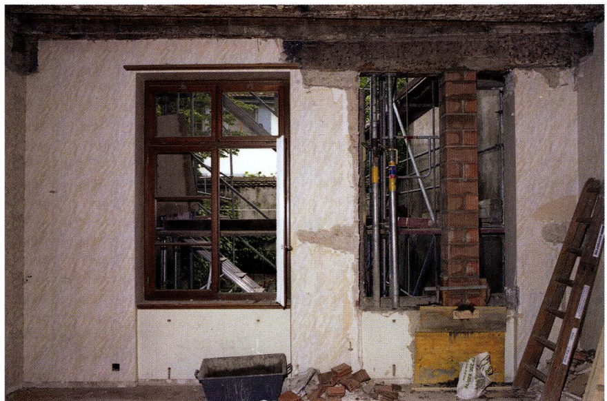
Abb. 11-3 Spalenberg 18 (2004/4). Hofseitige Mauer, Innenansicht im 1. Obergeschoss, Blick zum Hof. Der Fenstersturzbalken überspannt die gesamte Gebäudebreite und ist bis auf die Tiefe der halben Mauerstärke in die Brandmauern eingelassen. Die neuzeitlichen Fensteröffnungen übernehmen die Balkenkante als obere Begrenzung. – Foto: Basler Denkmalpflege.
