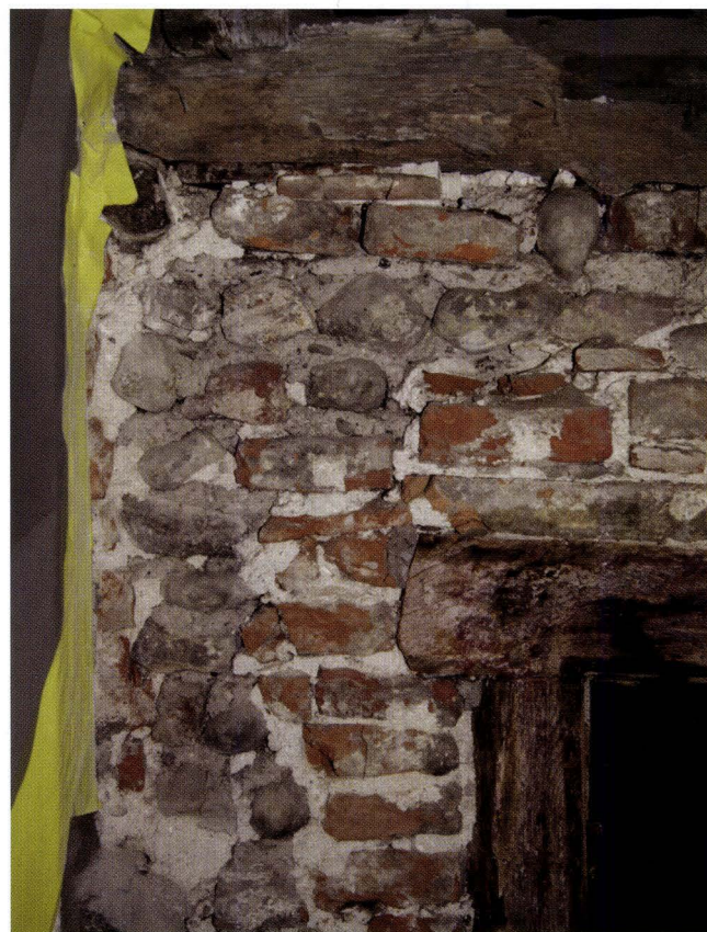
Abb. 12-7 Spalenberg 28 (2004 / 325). Ausschnitt der Hoffassade im Traufbereich. Deutlich sind die helle Einbau-Ausflickung für das mit Holz gefertigte Fenstergewände sowie der helle Einbaustreifen für die Dachschwelle zu sehen. Die Hofmauer selbst besteht v. a. aus Wackensteinen in grauem, grob gemagertem Kalkmörtel. – Foto: Basler Denkmalpflege.
