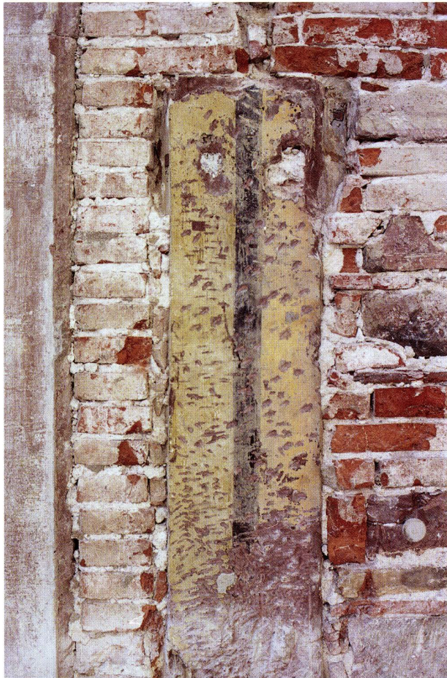
Abb. 11-16 Spalenberg 18 (2004/4). Strassenseitige Fassade, 1. Obergeschoss. Der obere Teil des zentralen Fensterpfostens trägt als letzte Fassung zwei verschiedene Ockertöne, welche offensichtlich den zwei Haushälften zuzuordnen und durch einen schwarzen Streifen voneinander abgetrennt sind. Ein erheblicher Teil der originalen Fensterflächen wurde beim Einbau der bestehenden Fensterrahmen vermauert. – Foto: Basler Denkmalpflege.
