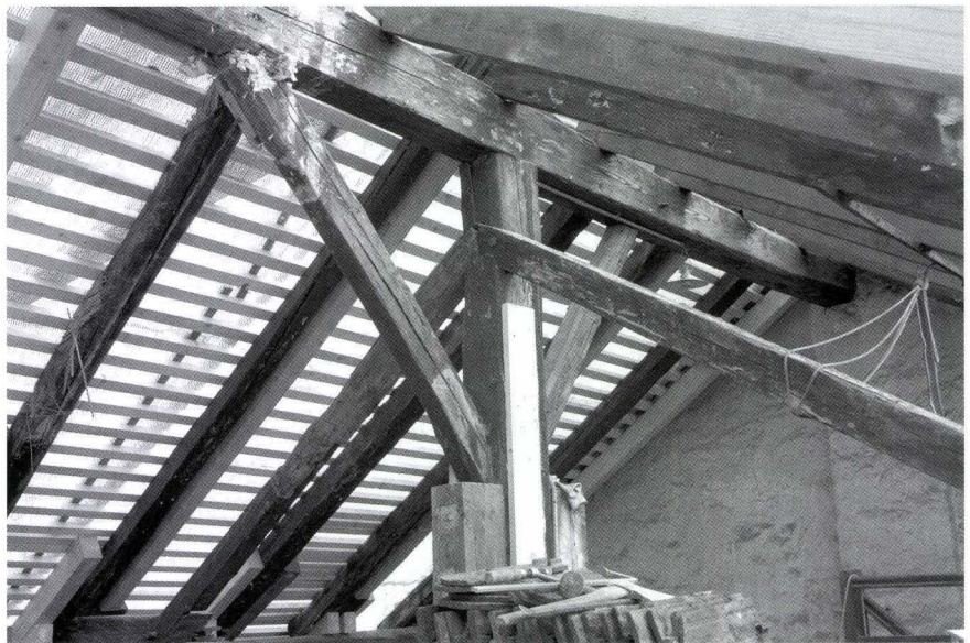
Abb. 11-17 Spalenberg 18 (2004/4). Stuhlkonstruktion von 1425 im Dachgeschoss. Firstständer und Firstpfette sind über Kopfbänder miteinander verstrebt. Die parallel zu den Rufen verlaufenden Steigbänder sind mit dem Firstständer verblattet. – Foto: Basler Denkmalpflege
