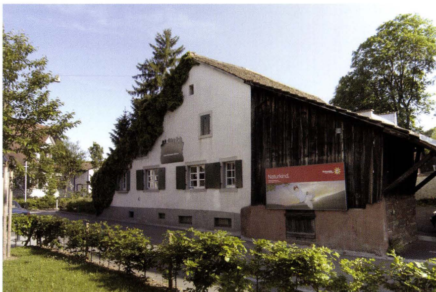
Abb. 4-1 Gartengasse 21, Riehen (2004/107). Das Gebäude Nr. 21 von der Gartengasse her in nordwestlicher Richtung gesehen. Nr. 25 steht hinter Haus Nr. 21. Zustand vor dem Umbau 2004. Die sichtbare Giebelwand stammt aus dem 19. Jahrhundert. Die für die Befunde wichtige Giebelwand (A in Abb. 4-2) steht im Innern des Hauses Nr. 21. Rechts der Schuppenanbau, der im Plan Abb. 4-5 nicht eingezeichnet ist. – Foto: Hans Ritzmann.
