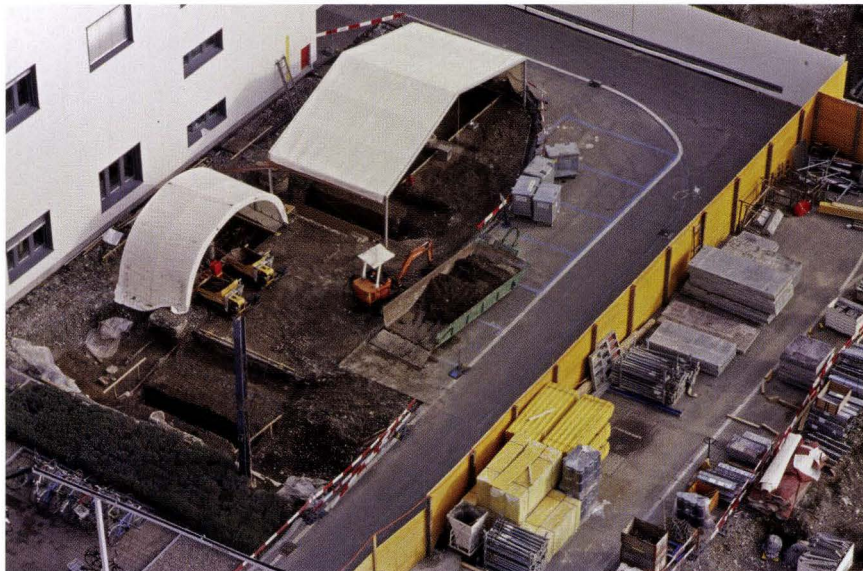
Abb. 37 Fabrikstrasse 40, Novartis Bau WSJ-433, 2004/37. Die Ostseite der Fläche wird untersucht; die Westseite wird als Zufahrtsweg und Operationsmöglichkeit für die Feuerwehr freigehalten. – Foto: Michael Wenk.
