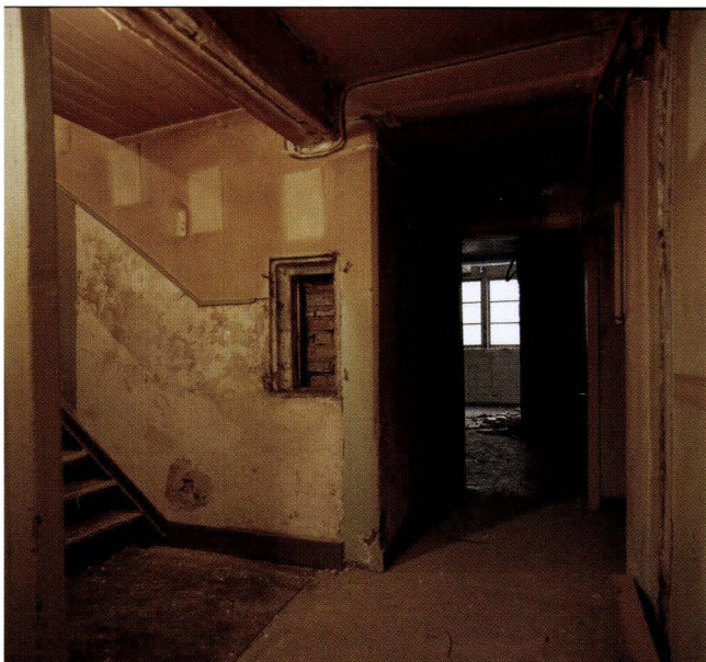
Abb. 7-3 Rebasse 11 (2003/435). Mittelgang im EG mit Blick gegen die Hinterfassade. In dieser Mauer hat sich links beim Antritt zur Treppe ein Fragment einer spätgotischen Fenstereinfassung erhalten. – Foto: Basler Denkmalpflege.
