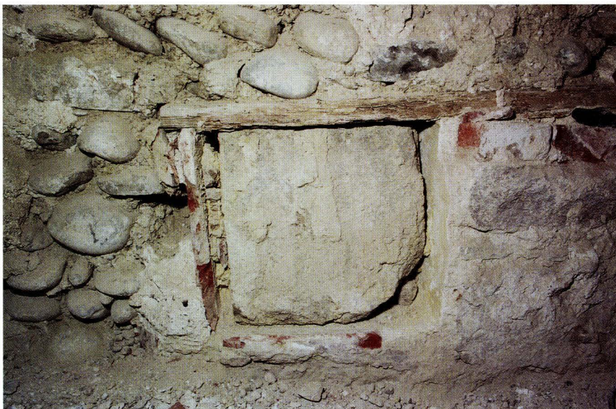
Abb. 14-3 St. Alban-Vorstadt 16 (2004/108). Erdgeschoss, westliche Brandmauer. Die verkleinerte Maueraussparung diente unter Beibehaltung des originalen Sturzbretts als Nische, bis sie schliesslich mit einem passgenauen Sandsteinquader vermauert wurde. – Foto: Basler Denkmalpflege.
