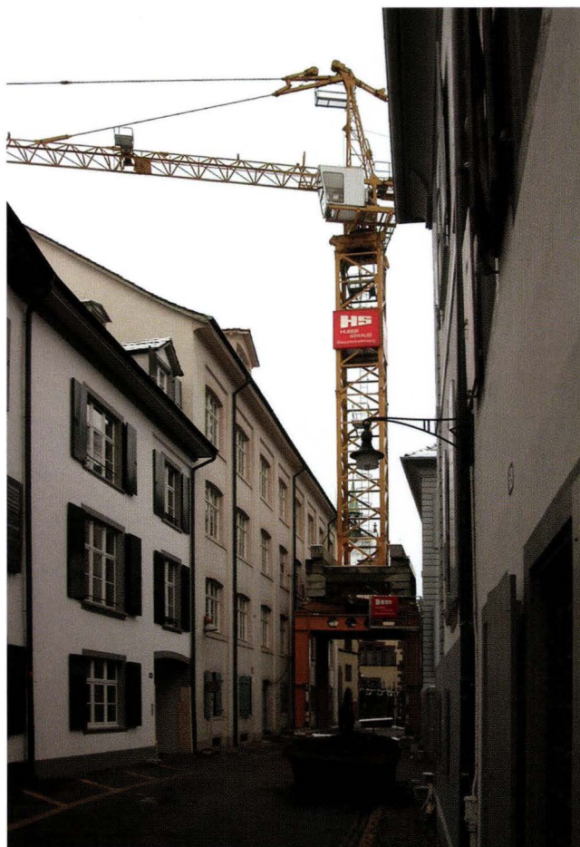
Abb. 1 Martinsgasse 6+8, 2004/1: Der Kran steht vor der Fassade des spätmittelalterlichen Ehrenfelderhofes mit der überbauten Hofdurchfahrt und dem Vorderhaus der ehemaligen Seidenbandfabrik. – Foto: Christian Stegmüller.
