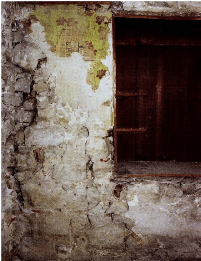
Abb. 10-22 Rössligasse 7, Riehen (2003/381). Aussenseite der alten Giebelfassade des Gebäudes von 1609. Ganz links die abgebrochene Mauer, die links die Hausecke zur Strasse formte. Daran anstossend ein sekundäres Mauerwerk, das eine Fensteröffnung ausbildet. Die Öffnung wurde später zum Wandkasten umfunktioniert. – Foto: Basler Denkmalpflege.
