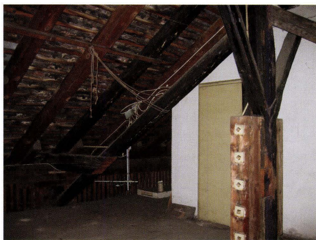
Abb. 7-6 Rebasse 11 (2003/435). Das dreigeschossige Dachwerk von 1489 ist in den unteren Geschossen mit liegendem Stuhl und im obersten mit einer stehenden Firstabstützung ausgeführt. Der Blick gegen die Hofseite zeigt einen Binder mit durchgesägtem Kehlbalken und Steigbandverstrebung. Im Vordergrund der mit angeblatteten Kopfbändern längsverstrebt Firstständer. – Foto: Basler Denkmalpflege.
