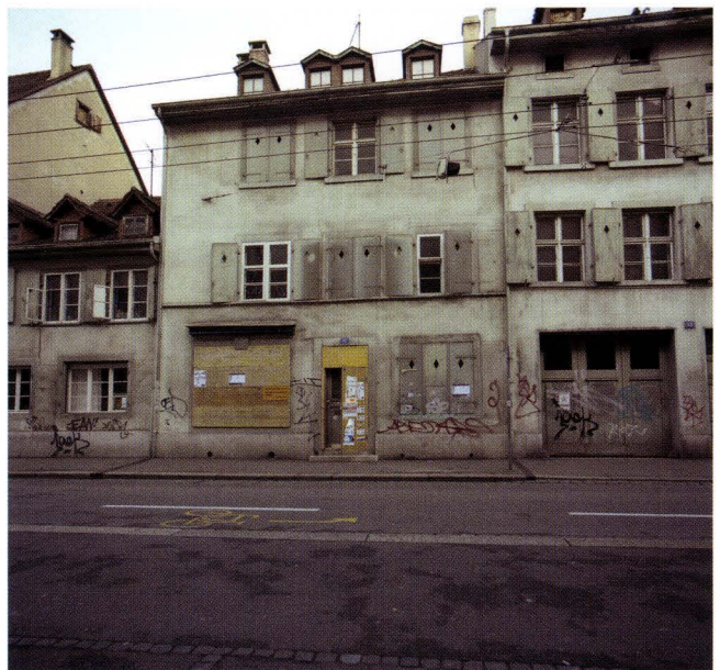
Abb. 7-2 Rebgasse 11 (2003/435). Strassenfassade vor der Sanierung. Das 2. OG entstand erst 1852 durch «Aufklappen» der Dachschräge. – Foto: Basler Denkmalpflege.
