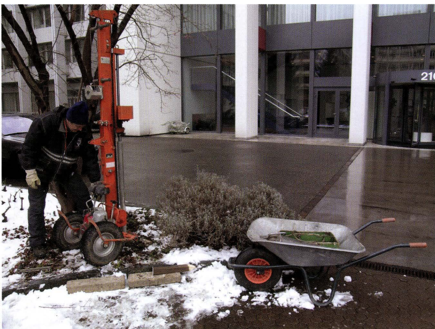
Abb. 29 Hünigerstrasse 84, Novartis, Sondierungen, 2004/33. Einschlagen einer Rammkernsondierung vor dem Bau WSJ-210. – Foto: Adrian Jost.
