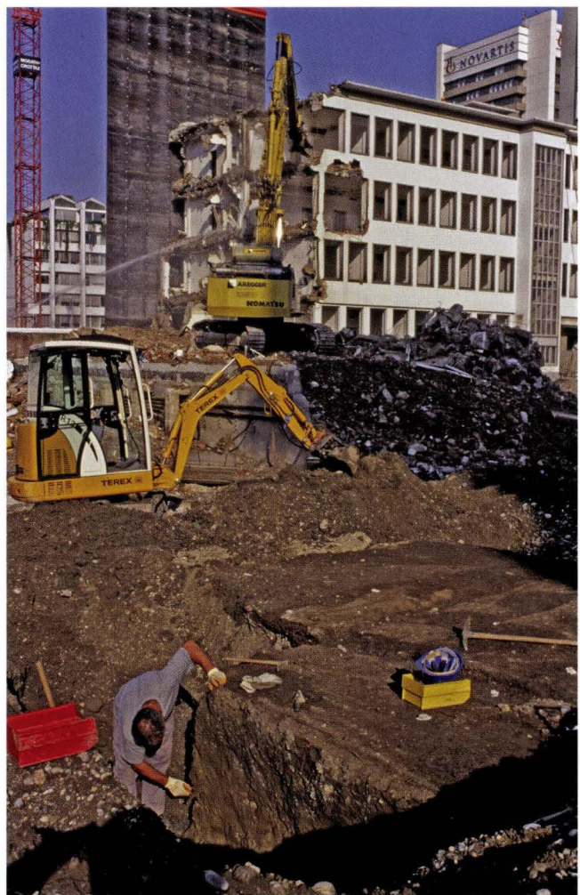
Abb. 24 Fabrikstrasse 40, Abbruch Novartis Bau WSJ-431, 2004/19. Im Vordergrund Südprofil der Grube 262A, im Hintergrund Abbruch des Baus 87. – Foto: Michael Wenk.
