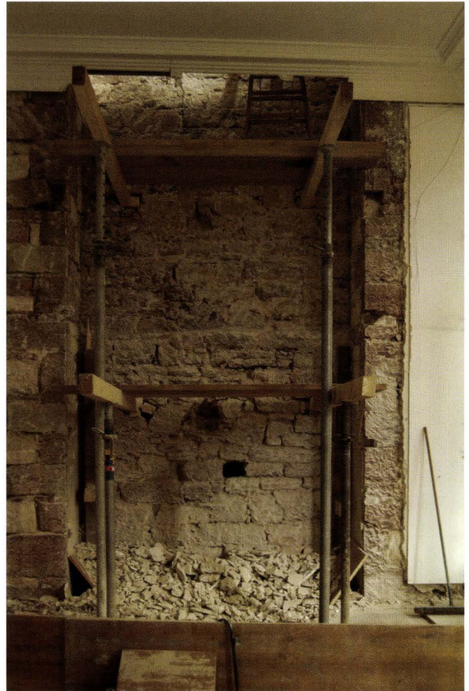
Abb. 16-5 Steinenberg 7, Kunsthalle (2003/431). Freigelegte Brandmauer im 1. OG im Treppenhaus. Die Nische war durch das Mauerwerk des Kunsthallenbaus von 1872 vorgegeben. Die Mauer im Nischenhintergrund hatte zu einem älteren Gebäude (ehem. Pfarrhaus) gehört, das 1872 abgebrochen wurde. Sie erstreckt sich seitlich hinter den Brandmauerflanken des Kunsthallenbaus in unbekannter Ausdehnung und vertikal über alle Geschosse. Hinter dieser Vorgänger-Brandmauer ist eine moderne Backsteinmauer des Nachbargebäudes aufgeführt. – Foto: Basler Denkmalpflege.
