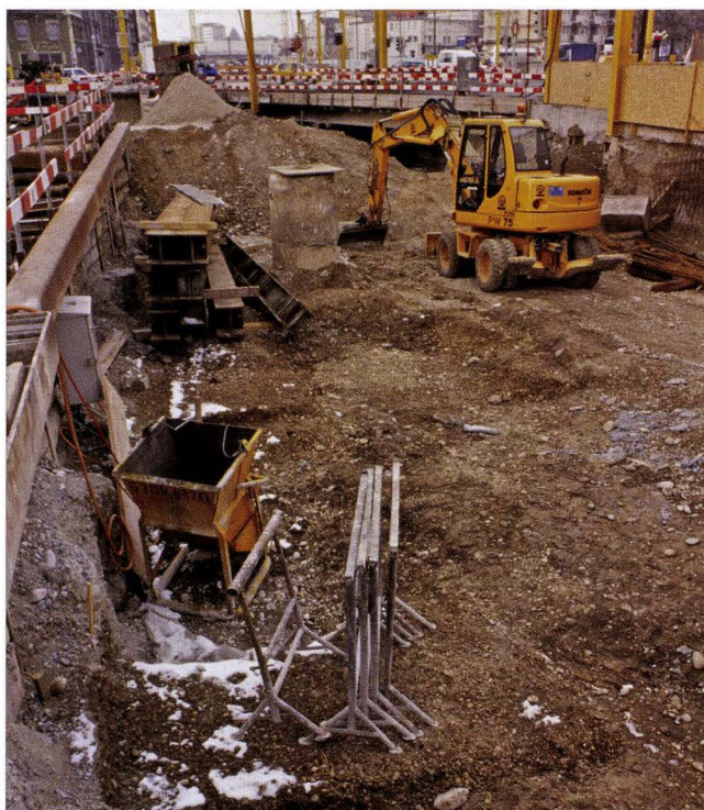
Abb. 6 Voltastrasse (A), TJO Süd, Etappe 3, 2003/67. Die Grabungen zwischen Autostrasse und Baustelle. – Foto: Philippe Wernher.
