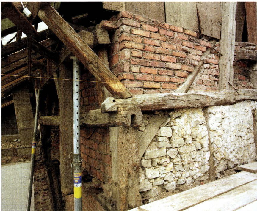
Abb. 4-7 Gartengasse 21, Riehen (2004/107). Blick von Südwesten auf den am besten erhaltenen Bereich der Hochstudkonstruktion von 1547. Auf dem Ständer E (links im Vordergrund) liegt der Rähmbalken U der Westwand mit sichtbarem Zapfenschlitz. Über Eck ist darauf der grob behauene Bundbalken S gelegt. Der Sperr-Rafen R steigt dahinter schräg auf. Backsteine, Riegelausfachungen und alle übrigen Balken/Bretter sind jüngeren Datums und trennen Haus Nr. 21 von Nr. 25. – Foto: Bernard Jaggi.
