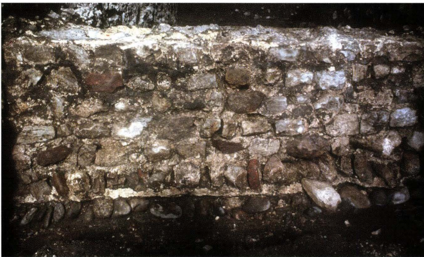
Abb. 18 Martinsgasse 6+8, 2004/1: Nord-west-Südost verlaufende spätrömische Mauer, mit einem Fundament aus trocken gesetzten Kieselwacken und einer vermörtelten Lage aus Bruchsteinen, sowie mit mehreren Lagen aufgehenden Mauerwerks. Das Stück ist Teil eines Mauerwinkels, der zu einem Gebäude gehörte, das bis weit in den Bereich der heutigen Martinsgasse gereicht haben dürfte. – Foto: Claude Spiess.
