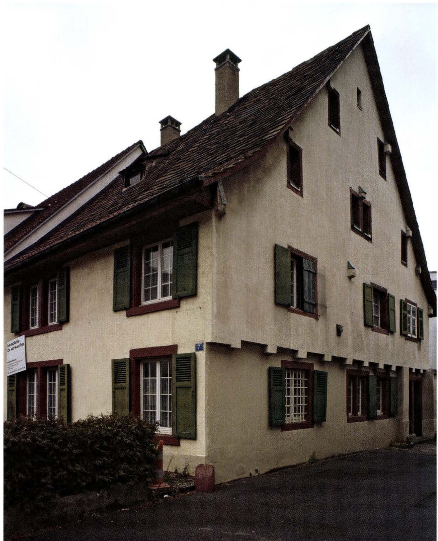
Abb. 10-5 Rössligasse 7, Riehen (2003/381). Giebelfassade vor der Renovation 2004. Deutlich erkennbar ist das vorgeschobene Fachwerk über dem gemauerten EG. Sämtliche ursprünglich sichtbaren Holzteile wie Balken- und Pfettenköpfe sowie das gesamte Riegelfachwerk sind mit einem Zementverputz überzogen. – Foto: Basler Denkmalpflege.
