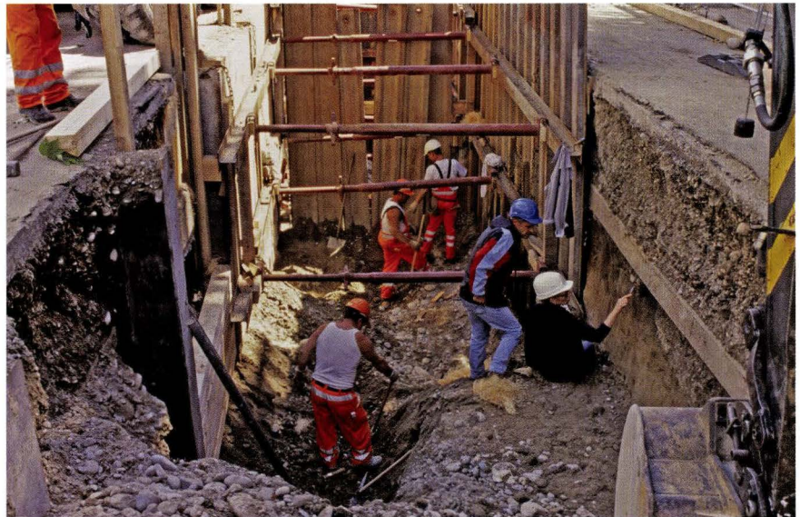
Abb. 20 Novartis, Fabrikstrasse 40, WAS-Leitung, 2004/3. Leitungstrasse in der Fabrikstrasse. Das West-Profil wird dokumentiert. – Foto: Michael Wenk.
