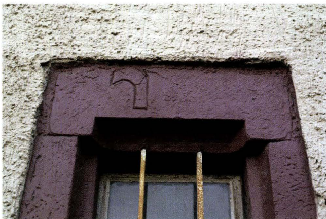
Abb. 10-6 Rössligasse 7, Riehen (2003/381). Kleines Fenster in der Hinterfassade, das ursprünglich den leicht erhöhten Abstellraum über der Kellertreppe beleuchtete. Das im Sturzstein eingemeisselte Rebmesser erinnert an den Bauernbetrieb. Die für den Sturz zu weit auseinander geschobenen Seitengewände sprechen für eine Zweitverwendung der Gewändesteine an diesem Ort. – Foto: Basler Denkmalpflege.
