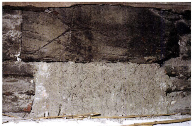
Abb. 11-10 Spalenberg 18 (2004/4). Strassenseitige Mauer, Innenansicht im 1. Obergeschoss. Eines der zwei kurzen, aber stark dimensionierten Sturzhölzer der heute vermauerten Öffnungen, welche sich über den Fensteröffnungen befanden. Das hier gezeigte Holz trägt eine über die ganze Balkenstärke eingekerbte Handelsmarke. – Foto: Basler Denkmalpflege.
