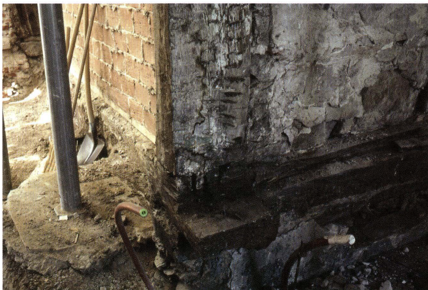
Abb. 4-8 Gartengasse 21, Riehen (2004/107). Blick von Südwesten. Der im unteren Teil abgeschrotete Ständer E steht auf einem kurzen Reststück der Längschwelle L, welche mit der von rechts ins Bild ragenden Querschwelle Q verblattet ist. – Foto: Stephan Tramèr.
