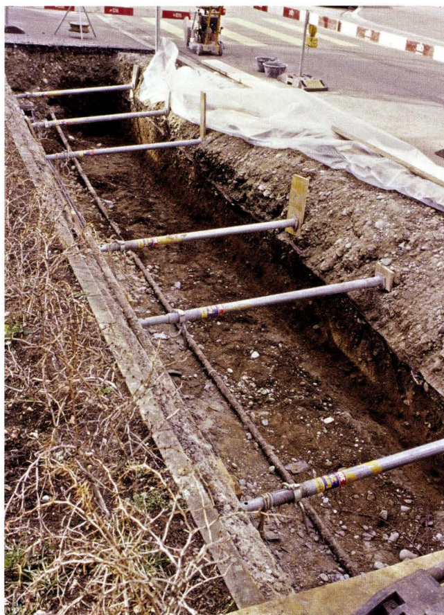
Abb. 5 Mülhauserstrasse (A), Anpassungen, 2003/52. Blick auf die intakte Schichtabfolge im Westprofil des Leitungsgrabens. – Foto: Daniel Miesch.
