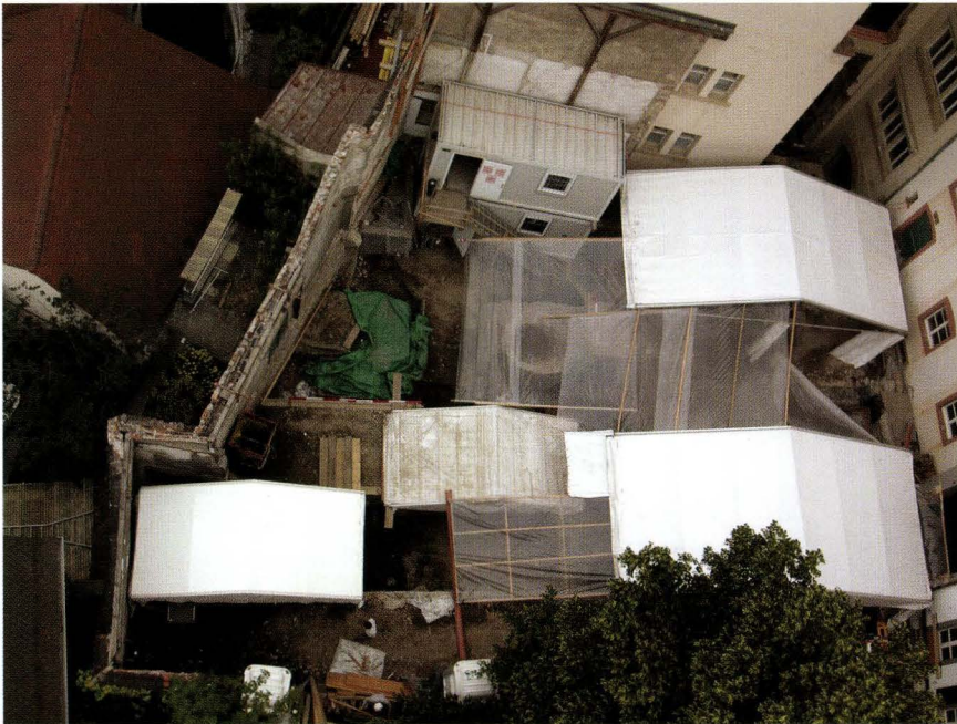
Abb. 2 Martinsgasse 6+8, 2004/1: Blick vom Kran auf den Innenhof mit Grabungszelten und Bürocontainern. – Foto: Christian Stegmüller.
