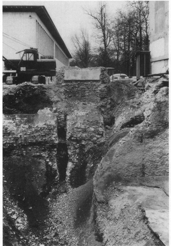
Abb. 16. Petersgraben 35, Bärenfelserhof; Fundstelle Nr. 22a. Blick von Osten auf die Innenseite der Inneren Stadtmauer und in das Halbrund des Schalenturms. Die Stadtmauer ist im Bereich unmittelbar hinter den Schenkeln des Turms, vielleicht wegen der Konservierung des Turmes, ausgespitzt (frische Bruchstellen!). Durch die Schlitzze ist die alte Abwasserdole zu sehen. Im Vordergrund rechts der untere Kellerboden des Bärenfelserhofes. Die noch stehende Mauer dahinter ist das südlichste bekannte Teilstück der Burkhardtschen Stadtmauer bis zum Spalenschwibbogen. – Foto: P. Heman.
