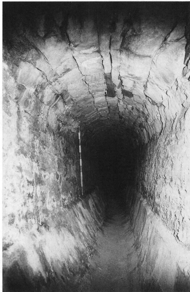
Abb. 13. Petersgraben 31, 1972/13; Fundstelle Nr. 20. Die Abwasserdole unter dem Haus ist noch durchgehend bis zum Evangelischen Pfarrhaus, Peterskirchplatz 8 (Fundstelle Nr. 16), begehbar. Aufnahmestandort: etwa beim Hebelndenkmal unter dem Peterskirchplatz. Blick nach Norden. – Dokumentation 1972/13: Foto 10.
