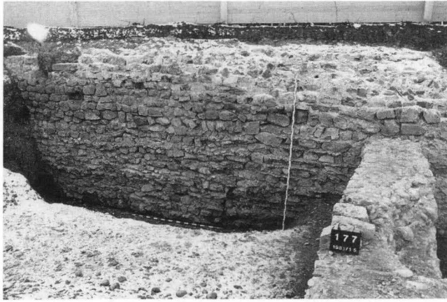
Abb. 24. Petersgraben 49/51, Rosshofareal, 1983/15; Fundstelle Nr. 25. Ansicht der Stadtseite der Inneren Stadtmauer mit angebautem Hofmauerfundament. – Dokumentation 1983/15: Foto 177.
