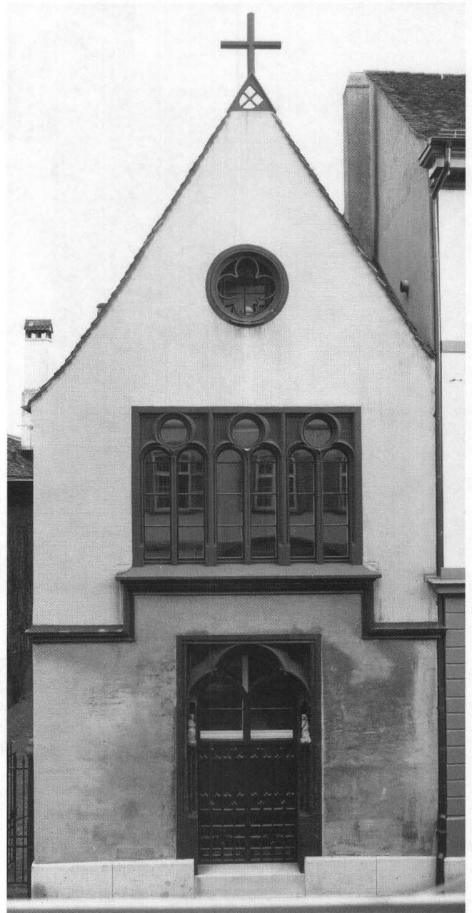
Abb. 4. Die von Melchior Berri 1844 umgestaltete Giebelfassade der Deutschritterkapelle an der Rittergasse Nr. 29. – Foto: Basler Denkmalpflege.
