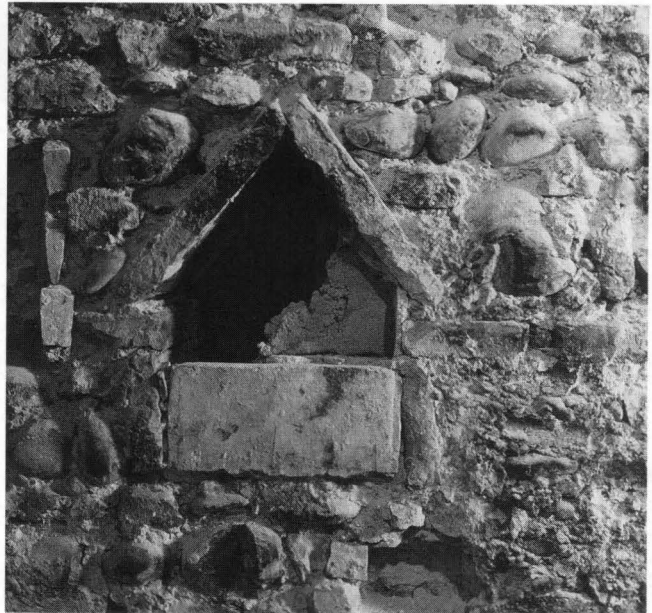
Abb. 4. Aeschenvorstadt 60/62, D 1986/12. Westbrandmauer des Vorderhauses Aeschenvorstadt Nr. 60 mit Spitzgiebelnische im ersten Obergeschoss. – Foto: Basler Denkmalpflege.
