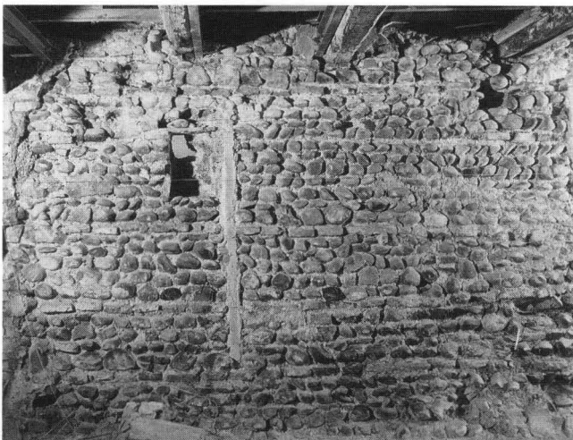
Abb. 5. Aeschenvorstadt 60/62, D 1986/12. Westbrandmauer im Erdgeschoss des Vorderhauses Aeschenvorstadt Nr. 60. – Foto: Basler Denkmalpflege.
