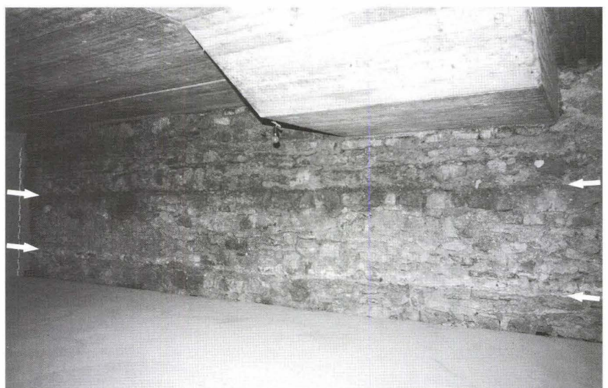
Abb. 13 Leonhardsgraben 43/Heuberg 22: Der Archäologische Keller zwischen den beiden Stadtmauern im Rohbau mit Blick auf die Innere Stadtmauer. Deutlich sind zwei Absätze (horizontale Bauetappen) sichtbar. – Foto: Archäologische Bodenforschung.
