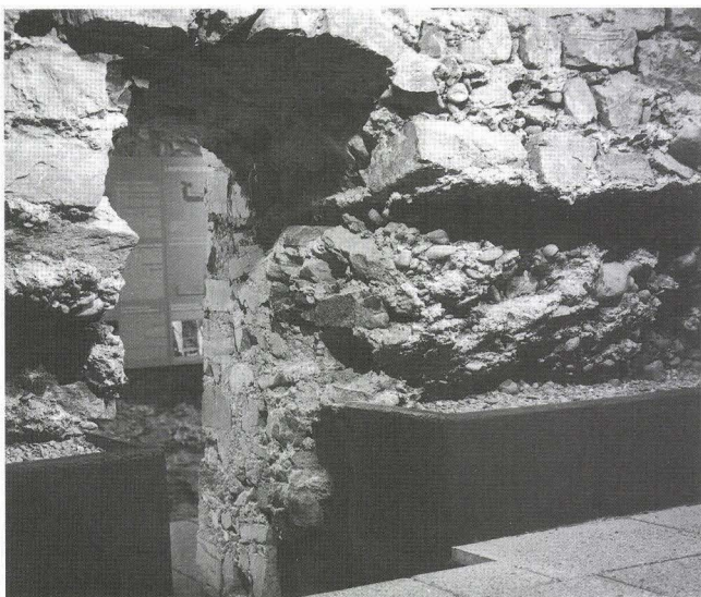
Abb. 23 Alter Teufelhof, Leonhardsgraben 47: Unterste, nachträglich unterfangene Fundamentpartie des angebauten Wehrturms. Links: Innenseite, rechts: Aussenseite. Der Durchgang ist modern. Deutlich ist an der Innenseite das sich gegen unten stufenförmig zur Front hin verjüngende Fundament ablesbar. An der Aussenseite beidseits des Durchbruchs zwei hohe schmale «Nischen»: Hohlräume der vergangenen Stützpfeiler aus Holz, eine Behelfskonstruktion während der Unterfangung.
