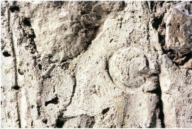
Abb. 86 Neuer Teufelhof, Leonhardsgraben 49: Kreisformen, eingedrückt in den noch weichen Putzmörtel der Burkhardtschen Stadtmauer (Aussendurchmesser: 5,5 cm). – Foto: Philippe Saurbeck.
