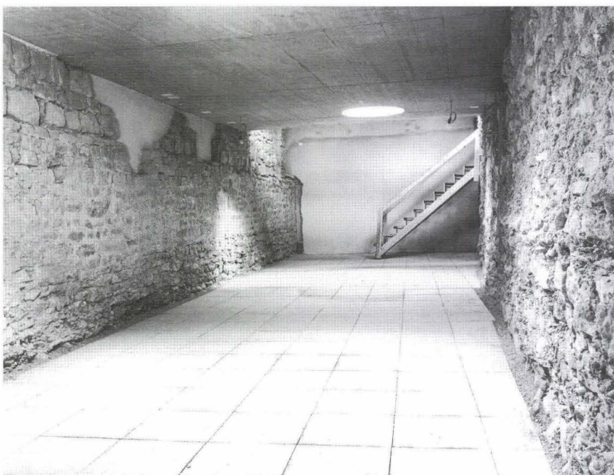
Abb. 92 Neuer Teufelhof, Leonhardsgraben 49. Die Archäologische Informationsstelle im Rohbau: links die Burkhardtsche, rechts die Innere Stadtmauer. – Foto: Thomas Kneubühler.
