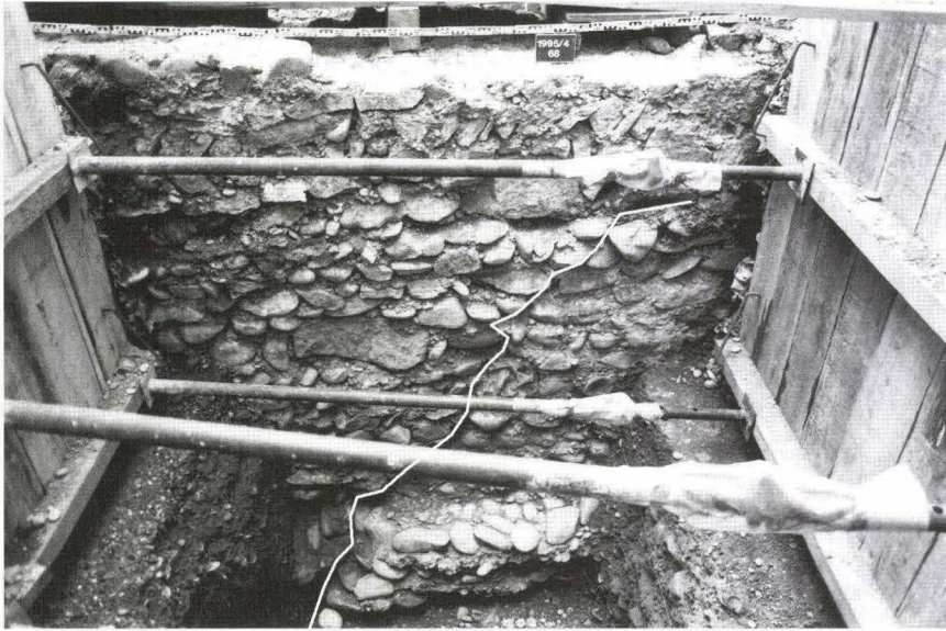
Abb. 21 Neuer Teufelhof, Leonhardsgraben 49: Blick auf die Rückseite der Burkhardtschen Stadtmauer. Deutlich ist zu unterst der vorspringende, nach oben rechts aufsteigende Fundamentteil zu sehen, an den die linke Fundamentpartie anbaut (entspricht der Grenzlinie Z/Z zwischen den Bauabschnitten C1 und C2 nach Beilage 2).
