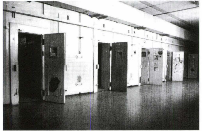
Abb. 33 Lohnhof: Hauptzellentrakt, Zustand zur Zeit des Gefängnisses vor dem Umbau (heute Musikmuseum). – Foto: Christian Bing.
