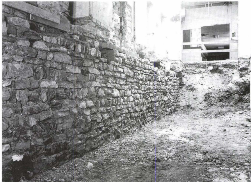
Abb. 35 Lohnhof: Blick auf die Rückseite der vom Eckturm nach Norden in Richtung Leonhardsgraben wegführenden Burkhardtschen Stadtmauer. Zustand nach dem Aushub des Kellergeschosses während des Umbaus. – Foto: Christian Bing.
