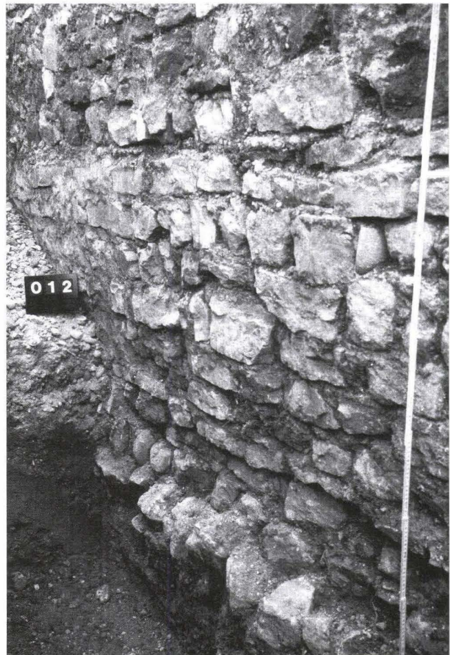
Abb. 4 Petersgraben 11: Blick auf die Rückseite der Burkhardschen Stadtmauer.
