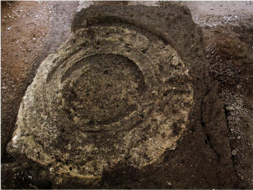
**Abb. 24** Martinsgasse 6+8, 2004/1: Überreste des hochmittelalterlichen Mörtelmischwerks mit konzentrischen Drehriefen und Staketenspuren im ausgehärteten Kalkmörtel; in der Mitte zeichnet sich die Vertiefung für die zentrale Spindel der Drehvorrichtung ab; sie ist noch mit lockeren Mörtelbrocken verfüllt. – Foto: Claude Spiess.
