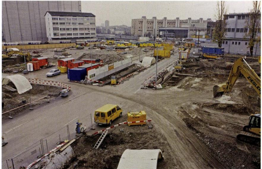
**Abb. 34** Fabrikstrasse 40, Novartis Parking Ost, Etappe 5, 2004/36. Übersicht über eine Fläche mit geschnittenen und freigelegten Gräben und Pfostengruben.
