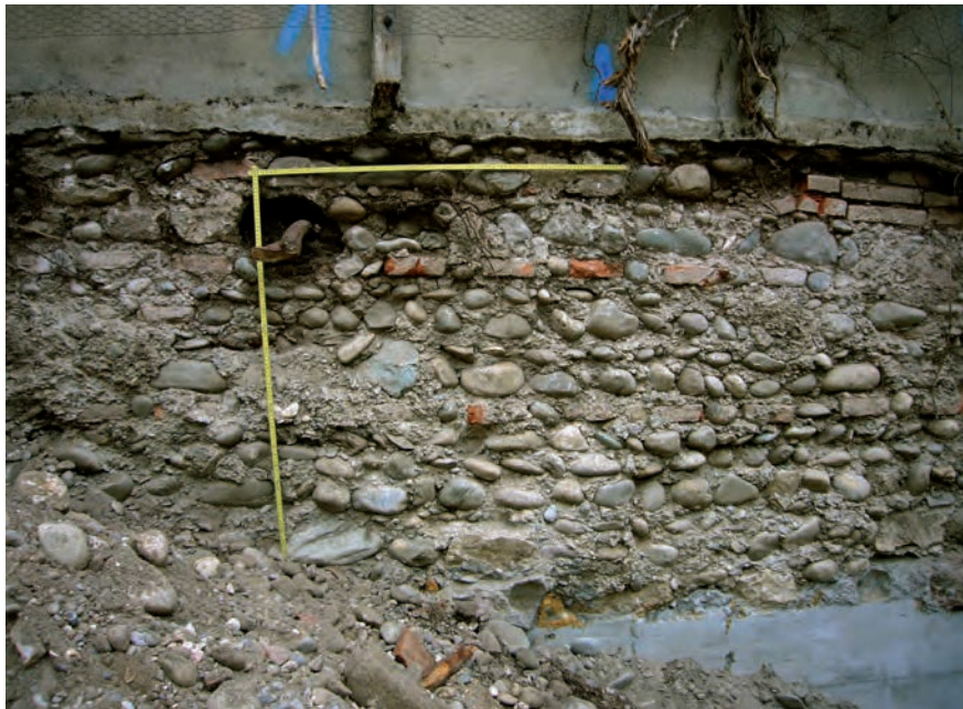
Abb. 9 Malzgasse 21, 2007/43. Das Fundament des Nachbarhauses Malzgasse 19 (Mauer 3) entspricht wohl der Hofmauer des auf dem Merianplan sichtbaren Gebäudekomplexes. – Foto: Christoph Matt.
