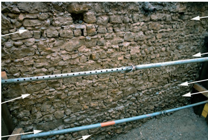
Abb. 30 Schanzenstrasse (A), 2008/26. Blick auf die dem Graben abgewandte Seite der Kontermauer. Die Pfeile verweisen auf die Grenzen zwischen fünf Bauetappen. Oben sind zwei Gerüstebellöcher zu erkennen. – Foto: Udo Schön.
