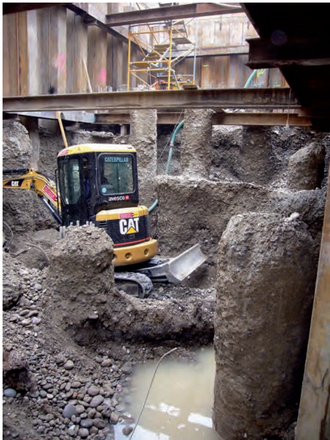
Abb. 23 Südquaistrasse 55, 2008/17. Blick auf die in sechs Metern Tiefe liegende Sohle der Baugrube. Die runden «Kiessäulen» sind die betonierten Bohrkerne, von denen derjenige vor dem Bagger einen Baumstamm durchbohrt hat. Dieser liegt horizontal vor dem Bagger zwischen den beiden Bohrkerne im Vordergrund. – Foto: Christoph Matt.
