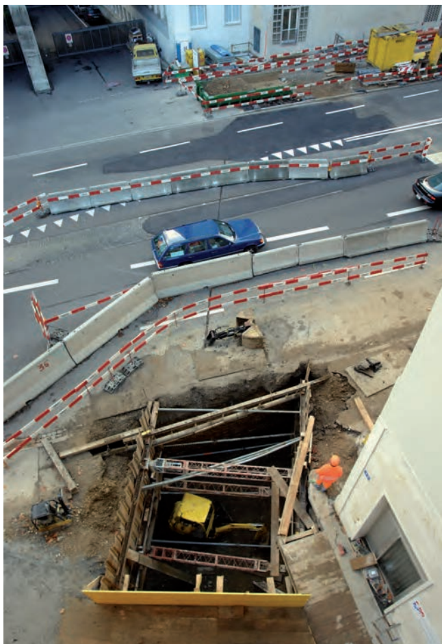
Abb. 27 Schanzenstrasse (A), 2008/26. Blick über das Trasse des Verbindungstunnels zwischen dem Kantonsspital und dem neuen Universitätskinderspital (UKBB). Die Fahrbahn entspricht dem Stadtgraben der Äusseren Stadtmauer des 14. Jahrhunderts, die strassennahen Baugruben-Abschränkungen bzw. Baugruben-Enden (Pfeile) markieren die eigentliche Stadtmauer (hinten) und die Graben- oder Kontermauer (vorne). – Foto: Udo Schön.
