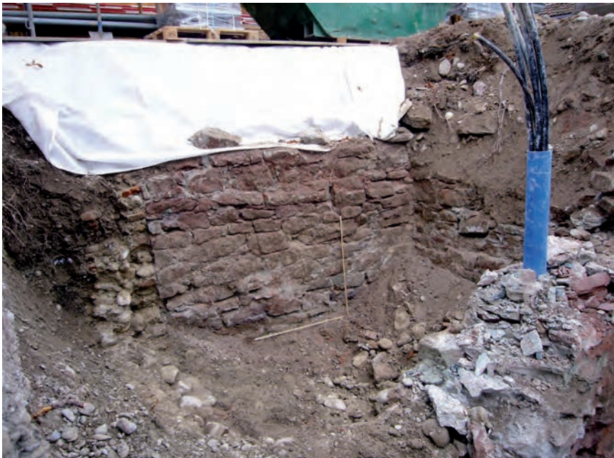
Abb. 7 Malzgasse 21, 2007/43. Blick in den Raum R des jüngeren Gebäudes aus dem 16. Jahrhundert. Die weisse Abdeckung liegt auf dem Gewölbekeller. Die abgebrochene Mauer links (Pfeil) ist die aus Kieselwacken und Backsteinen gebaute Kellermauer 20a. – Foto: Christoph Matt.
