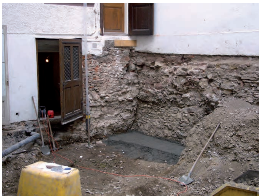
Abb. 20 Klosterberg 9, 2008/4. Blick in die nordöstliche Ecke des Hinterhofes zwischen dem tief liegenden Vorderhaus (links) und der südlich anstossenden, hier bereits abgebrochenen Laube, deren Türe zum Vorderhaus oben eben noch sichtbar ist. Gut erkennbar ist das zweiteilige Fundament der östlichen Hofmauer. Von links stösst die Basis der Hinterfassade des Hauses Klosterberg 9 an. – Foto: Christoph Matt.
