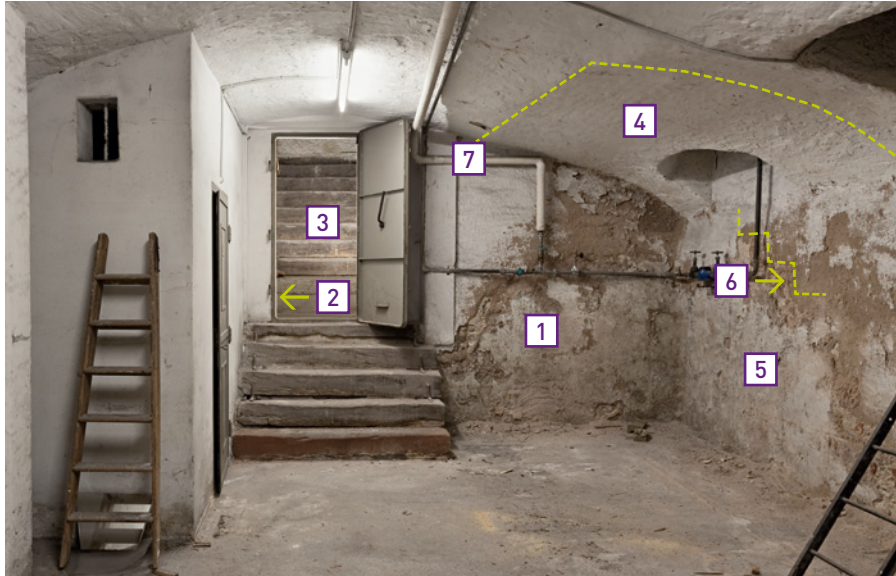
Abb. 10 Der Keller des «weissen Bären» im vordersten Teil des Gebäudes D. Hinten ist die Trennmauer (1) zum bergwärts anschliessenden Stichgang (2) und die Blocktreppe (3) zum Hof sichtbar. Im Stichbogengewölbe war einst eine Aussparung (4) für die frühere, der strassenseitigen Mauer (5) entlang verlaufenden Kellertreppe (Stufen 6) – der Bereich der vermauerten Aussparung ist auf der Abbildung am Knick des Gewölbes ablesbar (7). Foto: Conradin Badrutt.
