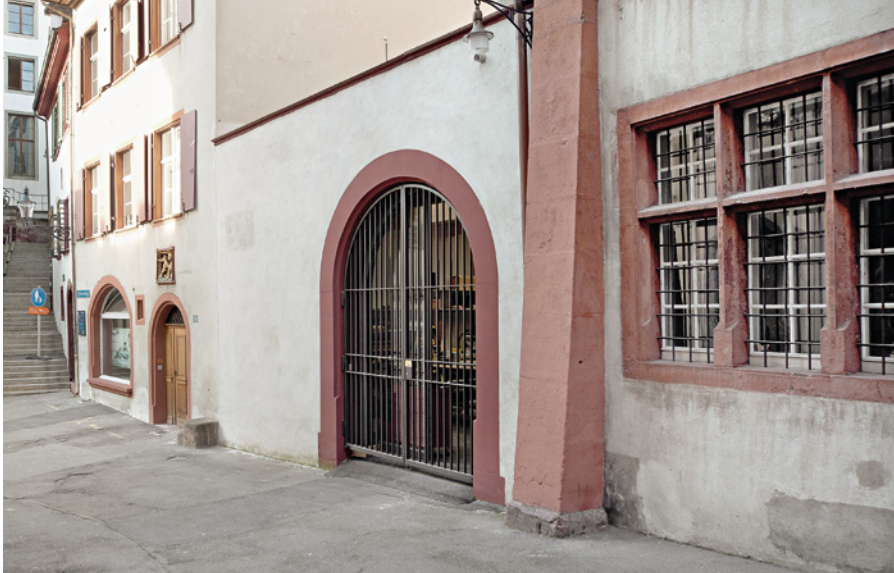
Abb. 21 Das Aussehen der Hofmauer vor dem Umbau von 1890 ist wiederhergestellt (mit modernem Gittertor). Dahinter befindet sich nun aber, ähnlich dem Setzersaal der Buchdruckerei, ein Raum mit Oberlicht für eine Werkstatt des Naturhistorischen Museums Basel. Foto: Philippe Saurbeck.
