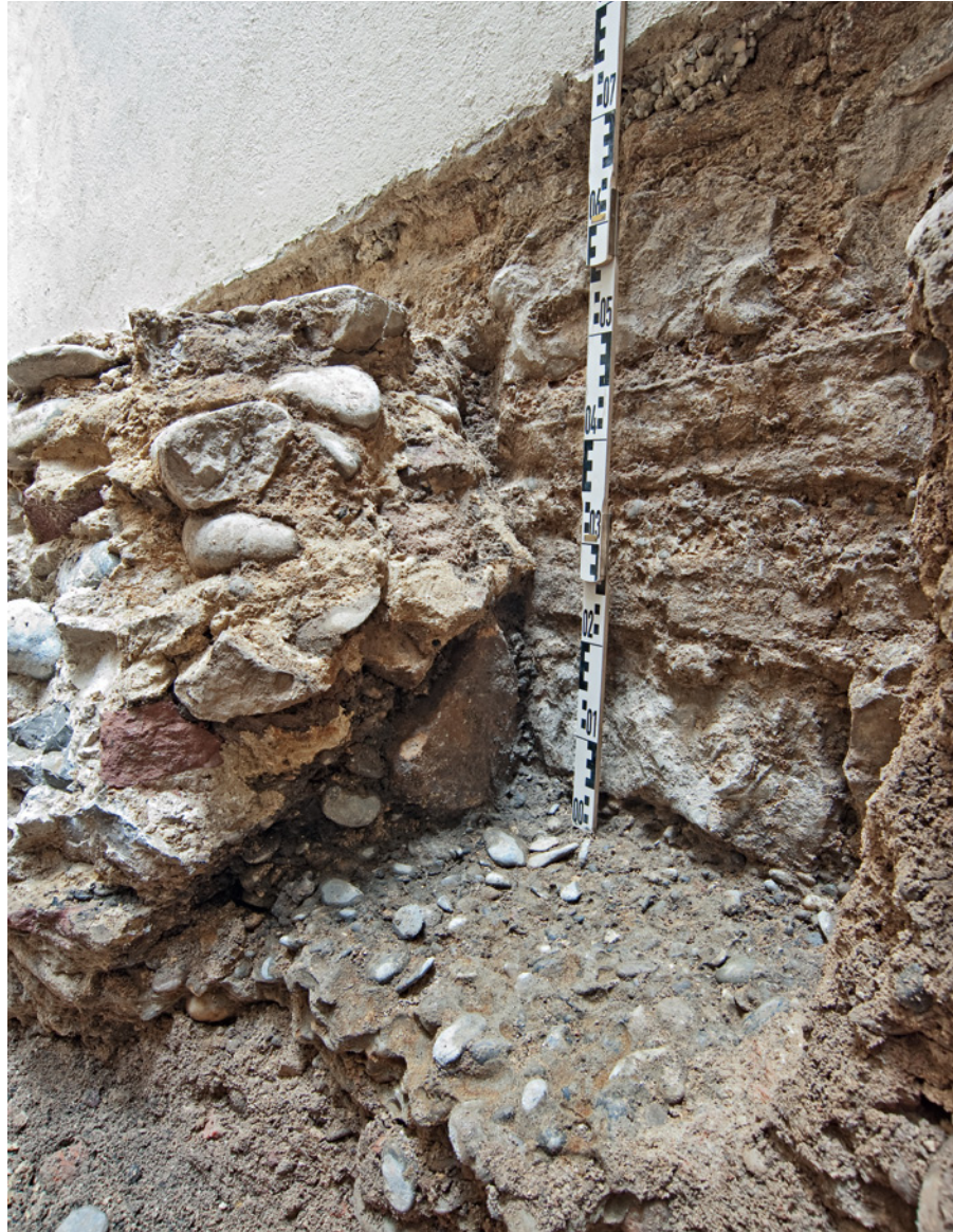
Abb. 5 Ein kleiner Ausschnitt der Hangstützmauer im Hof hinter dem Treppenturm. Die damaligen Baumeister erachteten den nagelfluhartig verdichteten Sand und Kies als ausreichend festen Untergrund — die Stützmauer hat jedenfalls mindestens 600 Jahre überdauert. Foto: Jan Baur.
