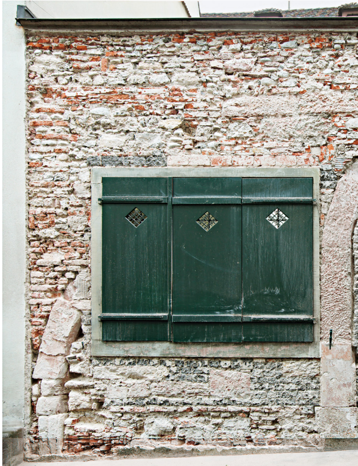
Abb. 17 Freilegungen am Mauerwerk des Setzersaals von 1890. Die alte Hofmauer zwischen Schlüsselberg 3 und 5 wurde damals nicht abgebrochen, sondern in die Fassade des eingeschossigen Neubaus eingebunden. Rechts ist das vermauerte alte Hoftor, links das ältere Tor der Vorgängerbebauung. Es dürfte sich dabei um den Überrest des früheren Hauses «zum wilden Mann» handeln, das erst bei der Anlage des Hofes abgerissen worden wäre. Foto: Conradin Badrutt.
