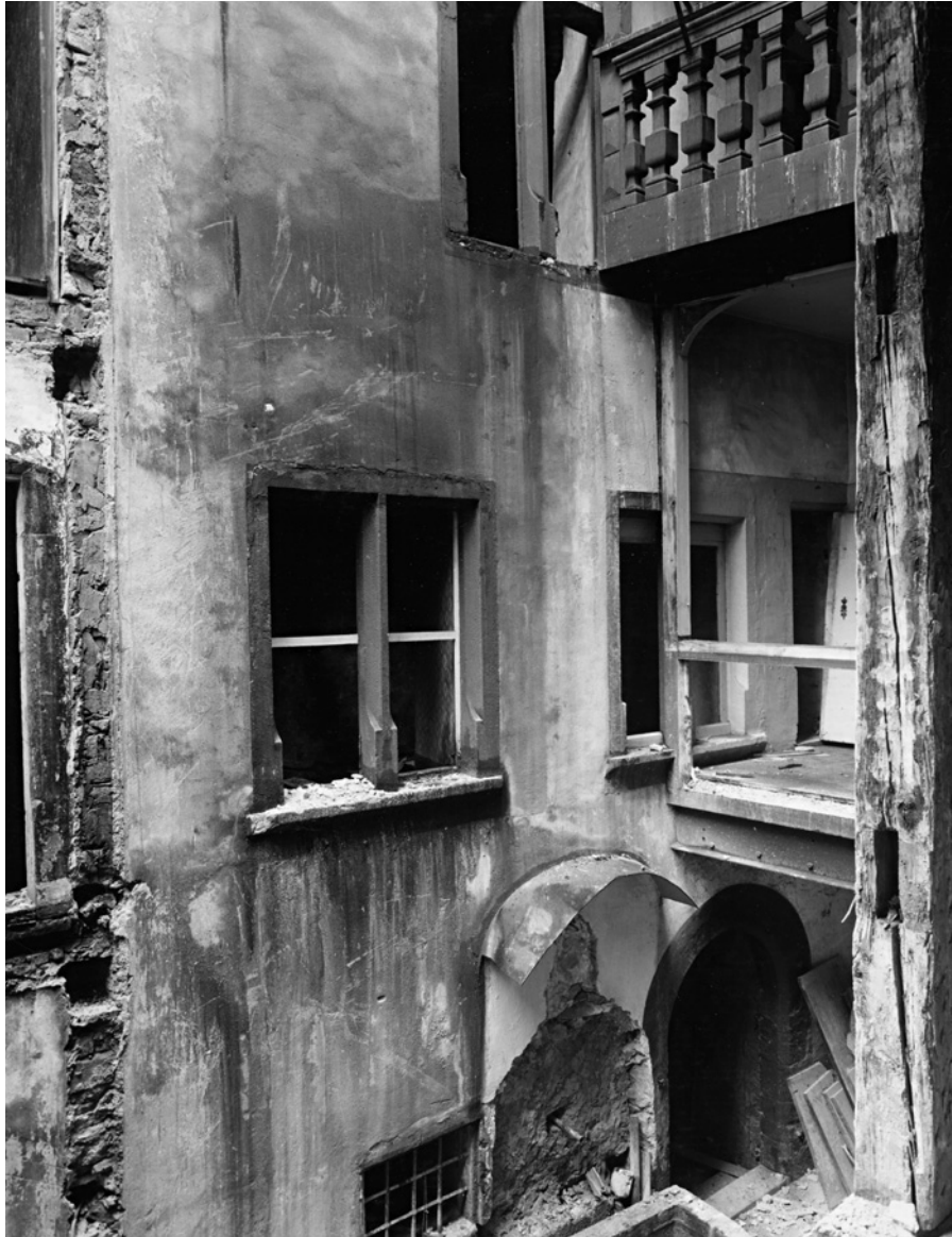
Abb. 6 Hinterhof der Liegenschaft «zum Venedig» zum Zeitpunkt des Abbruchs der Hoffassaden und Lauben um 1955. Die Hoffassade des Hinterhauses war die einzige Aussenmauer dieses in den Berg eingetieften «Höhlenhauses». Links neben der Eingangstür ist der bereits teilweise demontierte «Meerweibchenbrunnen» sichtbar. Foto: Peter Heman.
