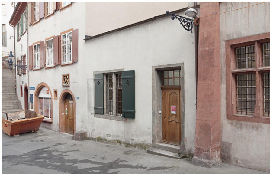
Abb. 20 Eingeschossige Fassadenmauer des Setzersaals von 1890 zwischen Schlüsselberg 3 und 5, Zustand vor dem Umbau 2011/12. Die unscheinbare Hausmauer lässt nicht vermuten, dass sie nicht nur den alten Torbogen des früheren Hofes, sondern auch Fragmente der Vorgängerbebauung enthält. Foto: Conradin Badrutt.
