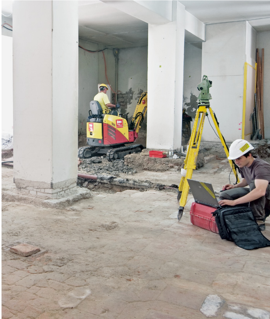
Abb. 2 Tachymetrische Aufnahme eines Bodens in Raum D durch den Zeichner Boris Ambiel, während im Hintergrund bereits der maschinelle Abtrag beginnt. Foto: Jan Baur.
