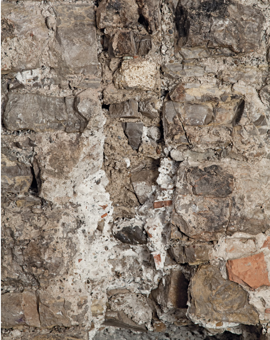
Abb. 7 Verfülltes Negativ eines Unterfangungs-Pfostens in der Stützmauer im Bereich des alten Hofes des Hauses «zum weissen Bären». Der Befund zeigt die traditionelle Technik der Unterfangung. Foto: Conradin Badrutt.
