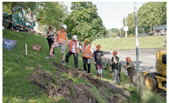
Abb. 52 Die Experten begutachten die Situation beim Baggerschlitze 2. Foto: Christoph Matt.
