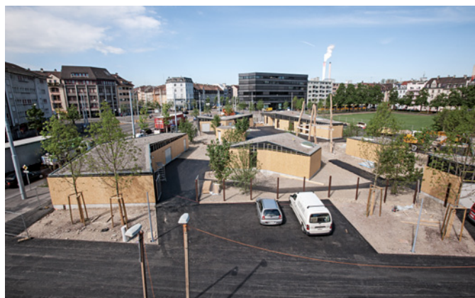
Abb. 38 Im Mai 2012 steht das Robidorf bereits im Rohbau. Foto: Michael Wenk.
