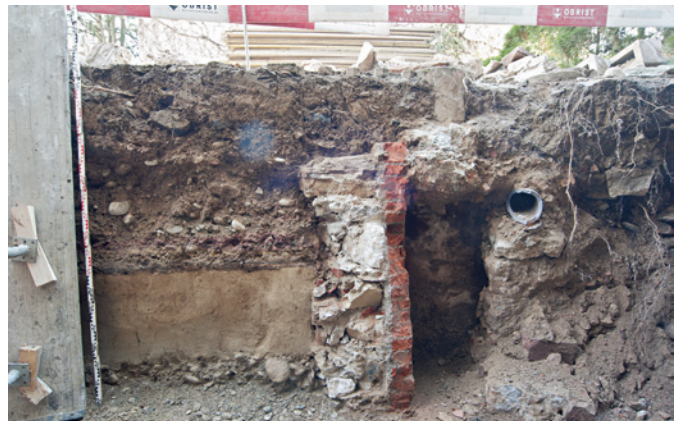
Abb. 51 Die Baugrubenwand im Hinterhof mit dem in Schwemmsand und glazialen Kies eingetieften Abwasserschacht. Foto: Christoph Matt.
