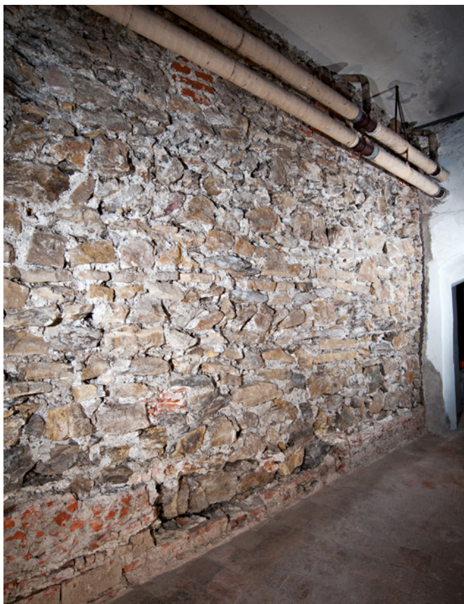
Abb. 20 Blick in den Seidenhof-Keller: die vom Putz wieder befreite Innenseite der Inneren Stadtmauer (Fundament). Foto: Christian Stegmüller.
