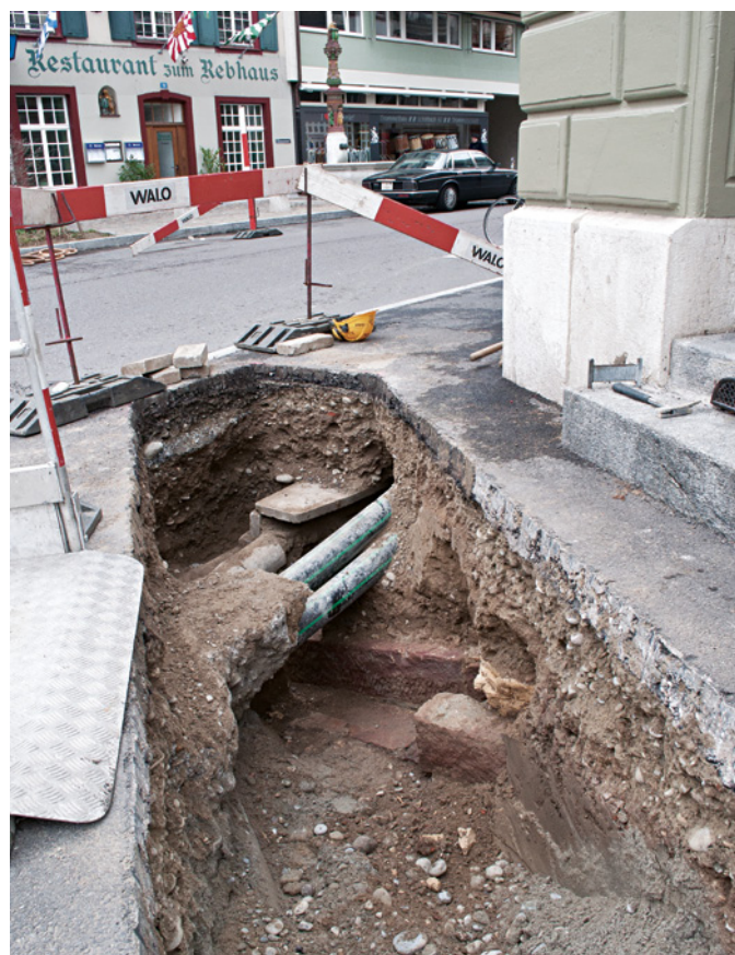
Abb. 19 Blick in den Leitungsgraben vor der Ecke des Hauses Kartausgasse 1 mit dem von einer modernen Leitung gestörten Abwasserkanal. Foto: Christian Stegmüller.
