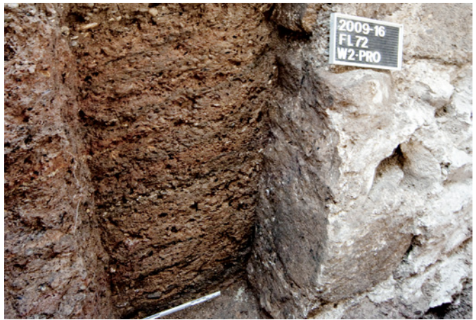
Abb. 6 Verfüllte Grube an der südöstlichen Kellerecke des ehemaligen Eptingerhofs. Gut sichtbar ist auch der massiv gebaute Eckverband. Foto: Philippe Saurbeck.
