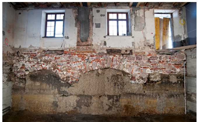
Abb. 18 Blick auf das hofseitige Fundament mit den Entlastungsbögen über Punktfundamenten (17./18. Jh.). — Deutlich sind darunter die verschiedenen modernen Unterfangungsetappen der hofseitigen Unterkellerung zu sehen, an denen noch die natürlich abgelagerten Erdschichten kleben. Foto: Christian Stegmüller.
