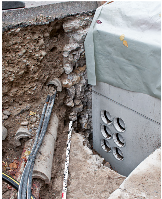
Abb. 28 Blick auf den Fundamentrest hinter dem Betonschacht im Leitungsgraben vor dem Hotel Basilisk. Foto: Christoph Matt.
