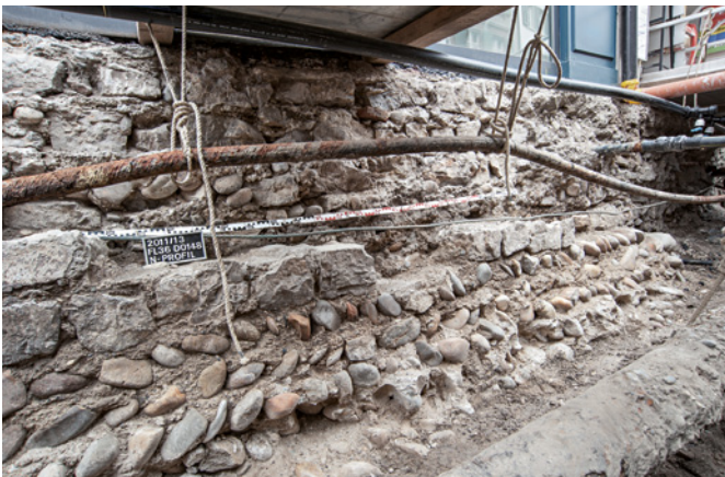
Abb. 14 Das den Häusern Spalenberg 58/60 vorgelagerte Fundament des Kernbaus (unten). Zurückversetzt (über dem Massstab) liegen die jüngeren aktuellen Hausfundamente. Foto: Christian Stegmüller.
