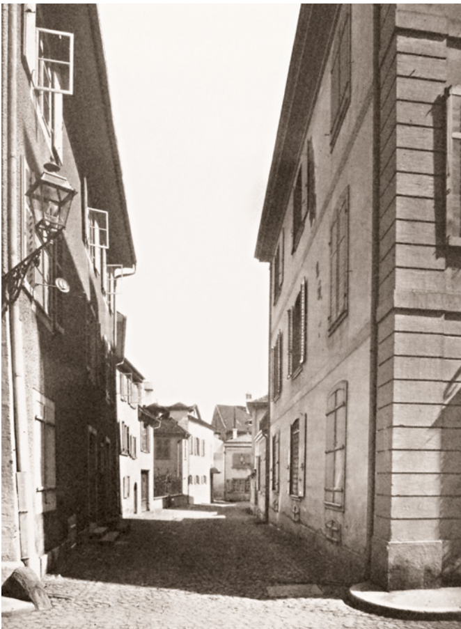
Abb. 11 Blick in die Stichgasse, die zum Hohenfirstenhof führt. Links die Vorgängerbebauung am Ort des heutigen Standesamtes. StABS NEG 2049, Fotoarchiv Wolf.
