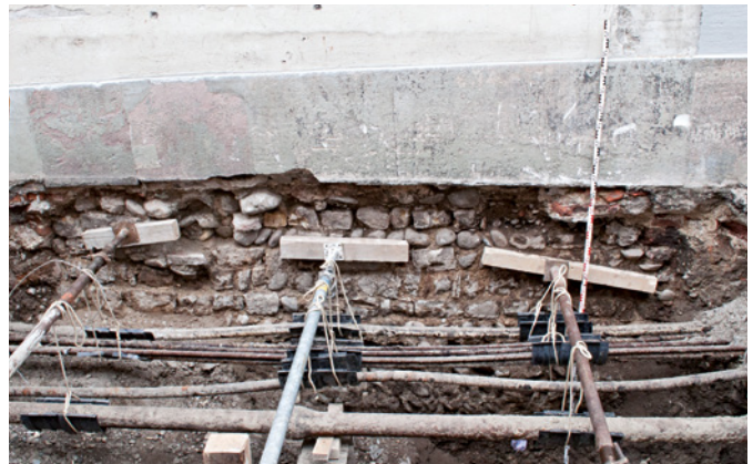
Abb. 25 Blick auf das Fundament der Hofmauer (wohl 13. Jh.). Foto: Christoph Matt.
