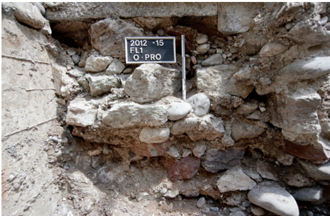
Abb. 9 Fundamentabschnitt der St. Ulrichs-Kirche. Foto: Marco Bernasconi.
