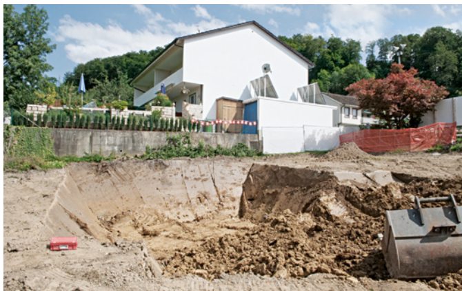
Abb. 53 Blick in die frisch ausgehobene Baugrube. Foto: Christoph Matt.
