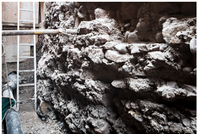
Abb. 5 Der unterste Abschnitt des Kellerfundaments des einstigen Eptingerhofs. Foto: Philippe Saurbeck.
