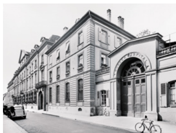
ABB. 3 Durch dieses mit «Bürgerspital Basel» überschriebene Tor gelangten die Kranken zum Pförtner, wo sie sich unter Vorweisung eines Arztscheins anmelden mussten. Foto: Alfred Kugler, StABS BSL 1012 1.
