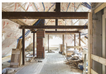
ABB. 5 Das Dachgeschoss am Petersgraben 11, in dem ab Frühjahr 2019 alle Büros und Labors der Archäologischen Bodenforschung untergebracht sind, wird komplett umgestaltet. Foto: Philippe Saurbeck.
